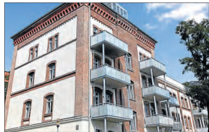
Endspurt: Wo einst Soldaten untergebracht waren, sind nun geräumige Mietwohnungen entstanden. Foto: Fischer
